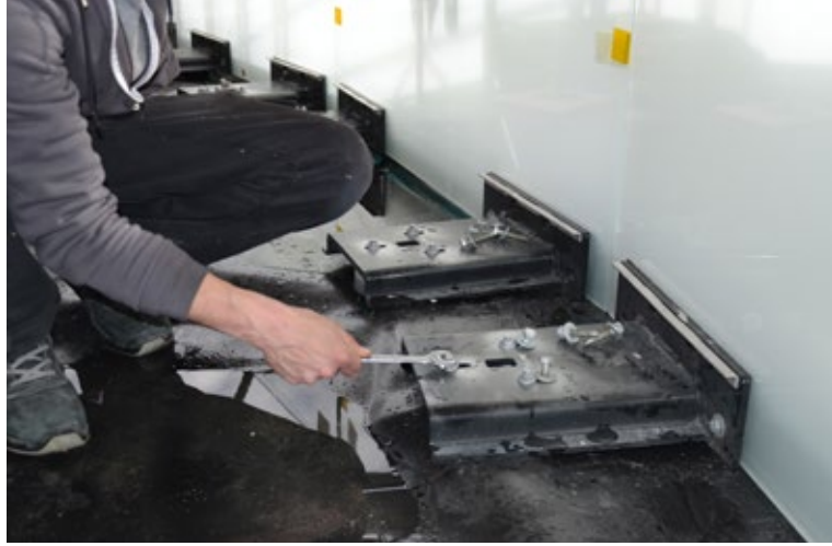
Die Glasscheibe lässt sich bequem über die hintere Gewindestange exakt vertikal ausrichten.
