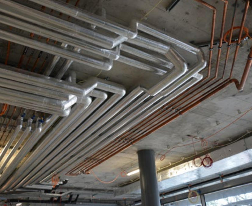
Sanitärleitungen Kalt-Warmwasser isoliert mit swissporKISODUR PIR Alu (Gitter)
