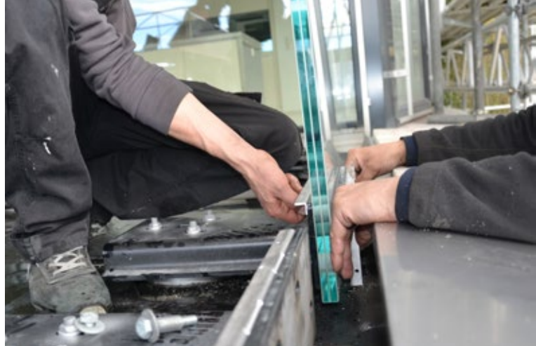
Das präzise Setzen der Glasscheibe in die vormontierte Glaskonsole 350 ist mit wenigen Handgriffen erledigt.
