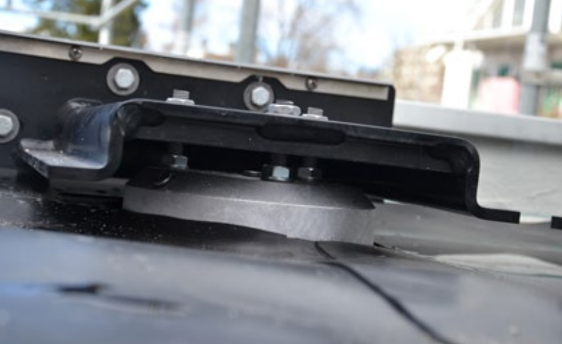
Die Glaskonsolen 350 wurden auf die drei Gewindestangen der UK I Beton 0-60 mm montiert.
